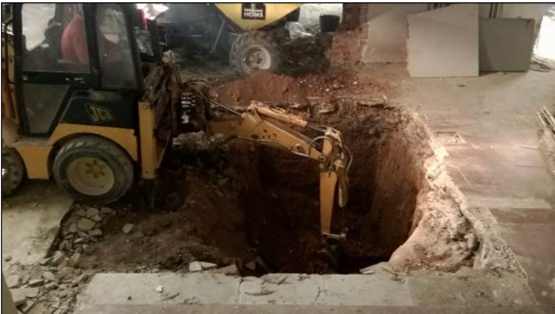
Procés d'excavació per al fossat del muntacàrregues
