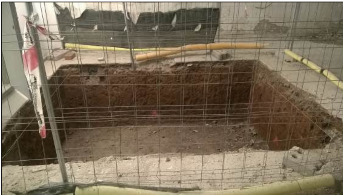
Fossat de l'ascensor un cop excavat
