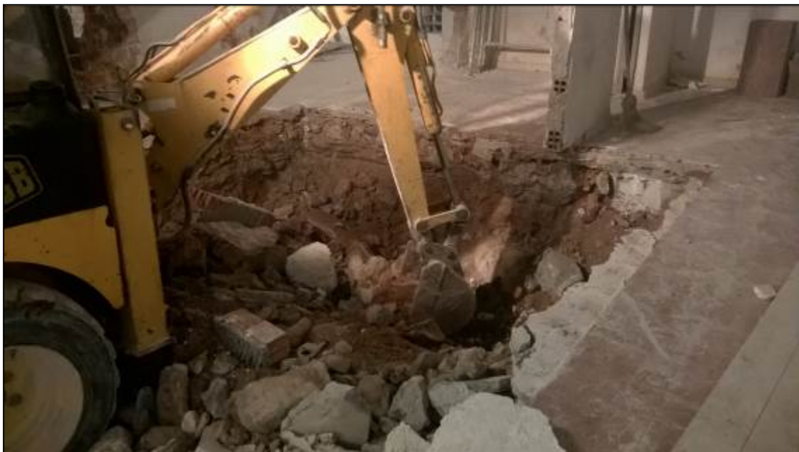
Inici de l'excavació i ampliació del fossat per al muntacàrregues
