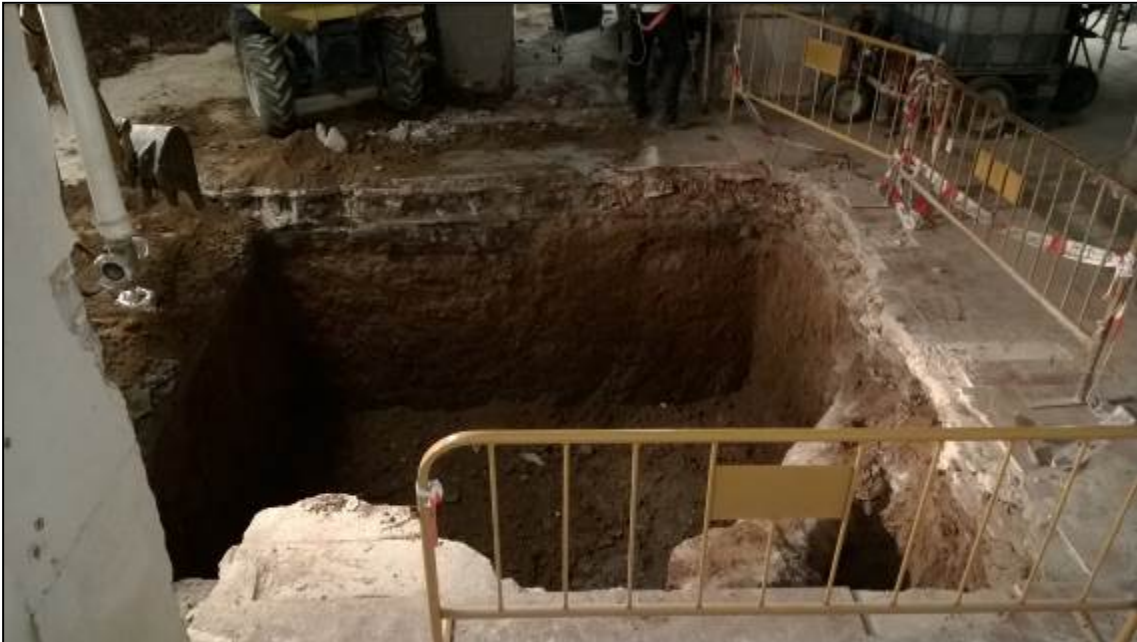
Fossat per al muntacàrregues un cop finalitzat
