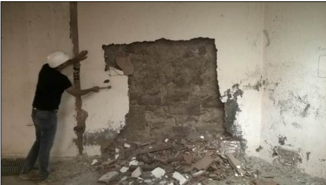
Procés de realització manual de la primera cala de comprovació
