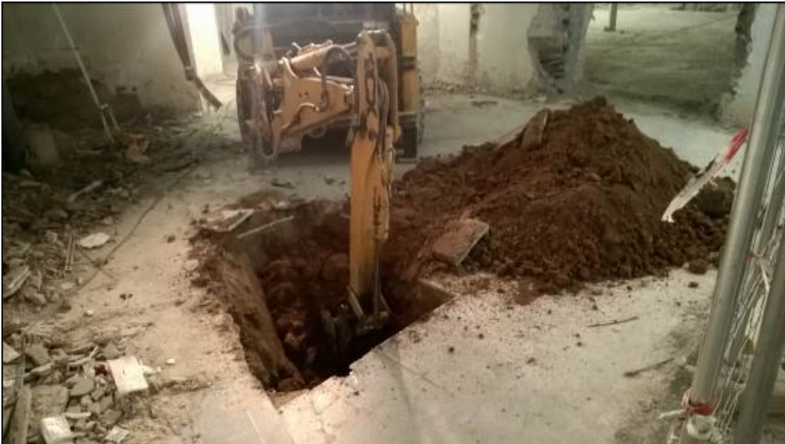
Procés d'excavació del sondeig de comprovació
