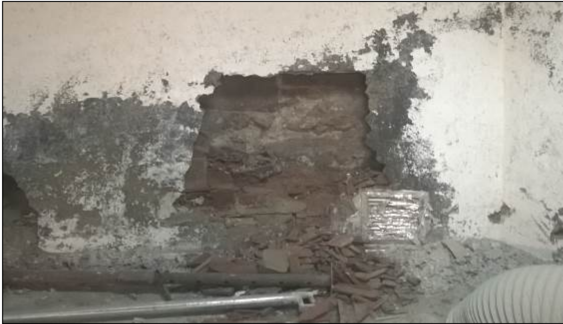
Obertura realitzada a la paret nord de l'edifici
