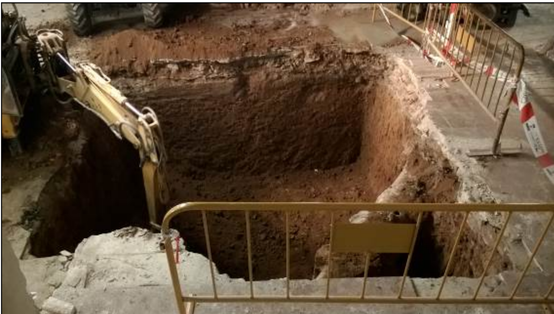
Feines d'excavació del fossat pel muntacàrregues
