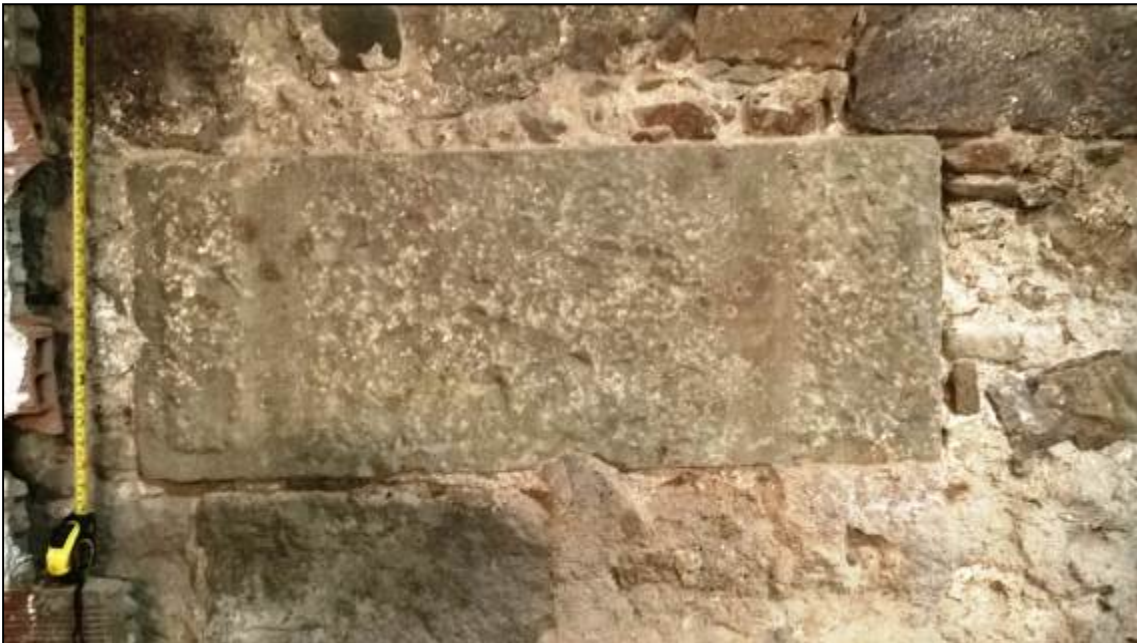
Dues imatges de detall del probable carreu d'origen romà reutilitzat per a la construcció del mur
