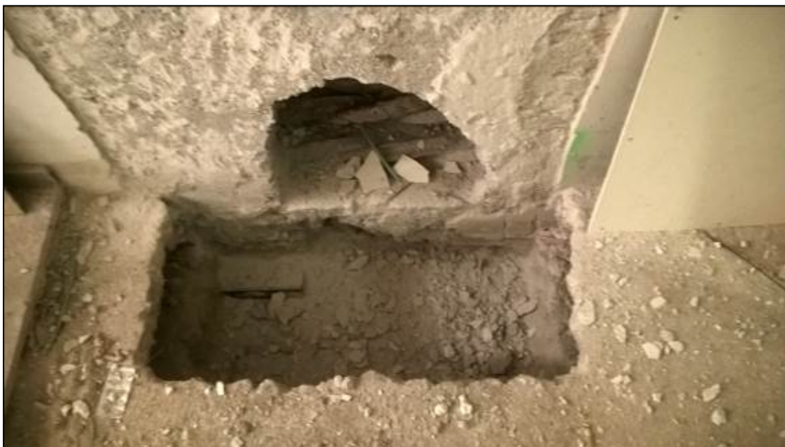
Dues imatges de dos dels sondejos realitzats per al reforçament dels pilars existents
